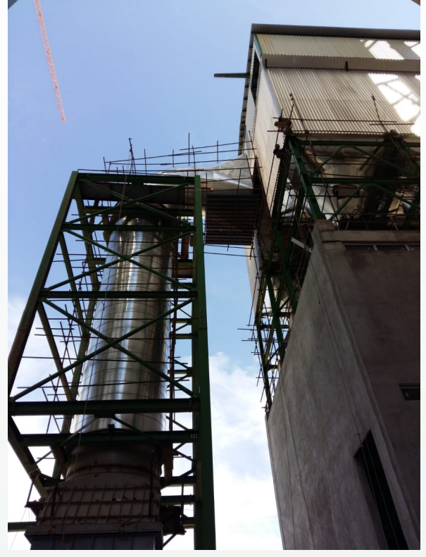
Boru ve Filtre İzolasyonu
